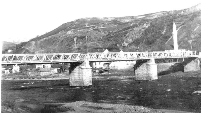
Fotografija 3 95 : Prijepoljski most u Šarampovu posle Drugog svetskog rata. Na slici se vidi modernizovani most izrađen od metala, oslonjen na betonske stubove, sa minaretom u pozadini.
